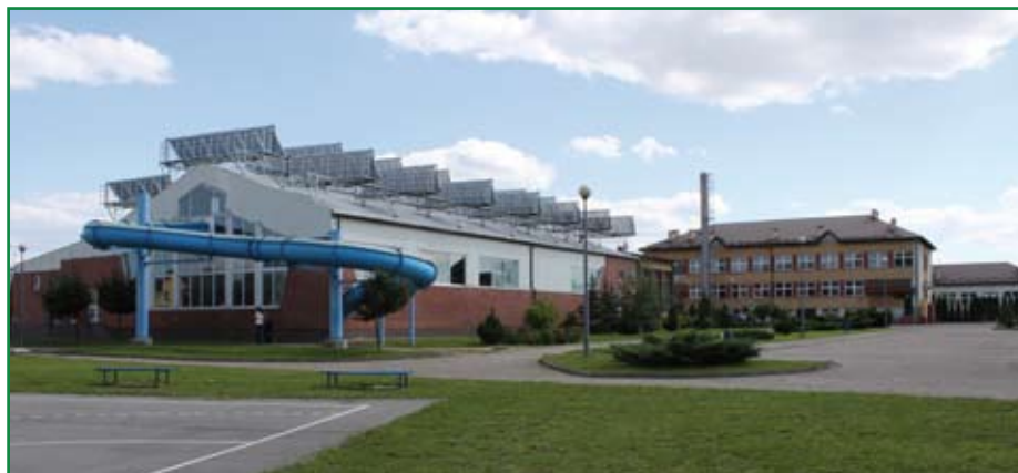
Cmolas – nowoczesna kryta pływalnia wraz z halą widowiskowo-sportową modern indoor swimming pool and cultural and sports facilities
